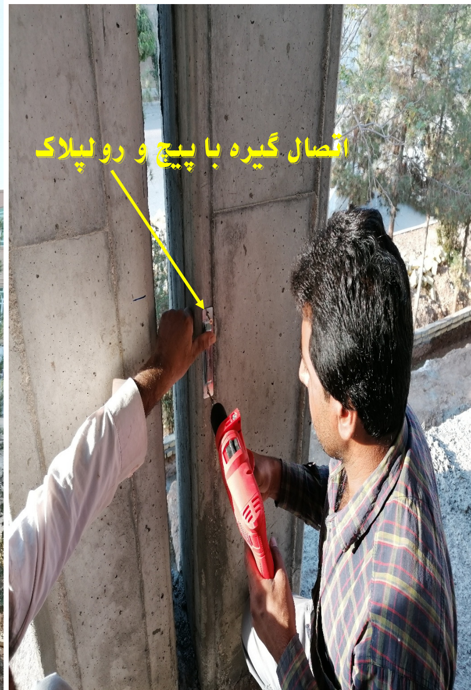
سوراخکاری در خارج از کاور بتنی
