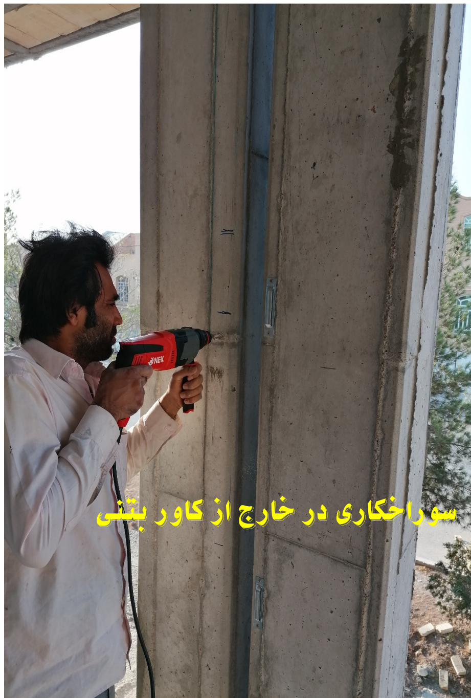
اتصال گیره با پیچ و روئپلاک
